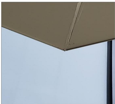
圖 15: 露台頂全條裂逢修補
